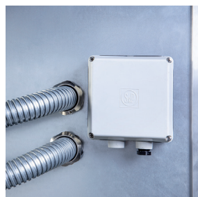
Aansluitdoos voor de servomotoren
